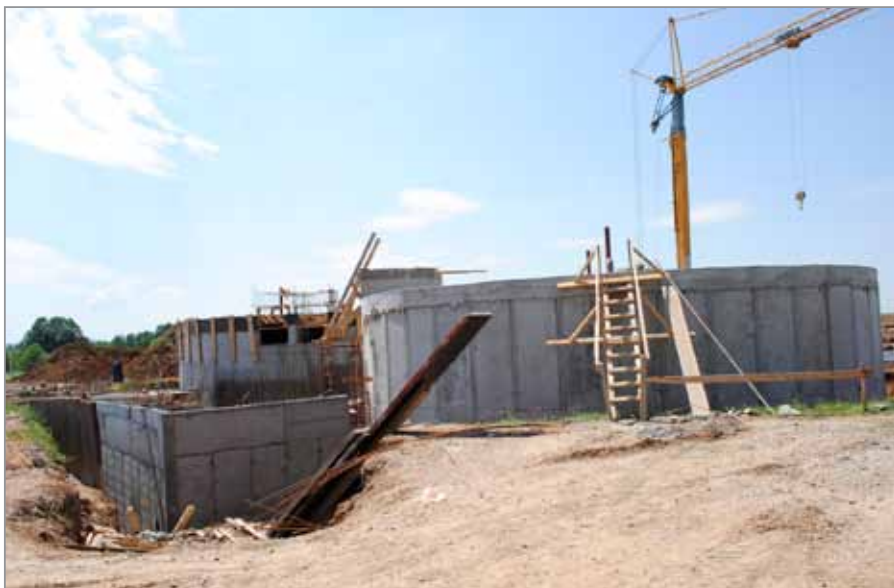
Резервоар Врелине - радови добро напредују
