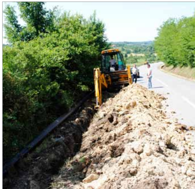
ЈКП 10. октобар извођач радова на полагању цеви
